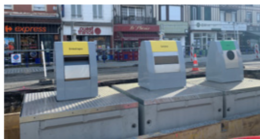
Plus de bacs en plastique sur le boulevard mais des points d'apport volontaires enfouis.
