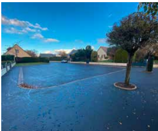
Réfection de voirie du lotissement Le Clos des Oiseaux.
