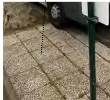
Dalle béton avec joint en mauvais état
